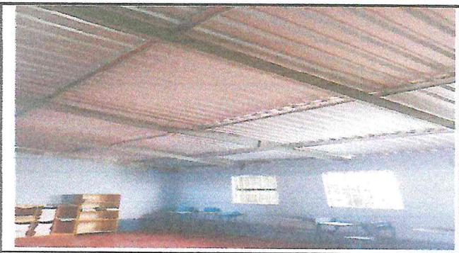
Foto 3: láminas troqueladas instaladas en aulas y corredor garantizando la seguridad del techo del centro educativo.
