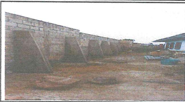
Foto 1: muro perimetral reforzado con 10 columnas fundidas que garantizan la seguridad y sostenibilidad del mismo.
