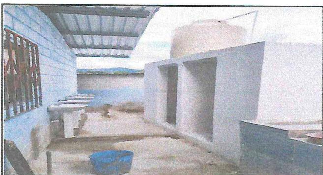
Foto 4: baños terminados con todos sus accesorios instalados.
