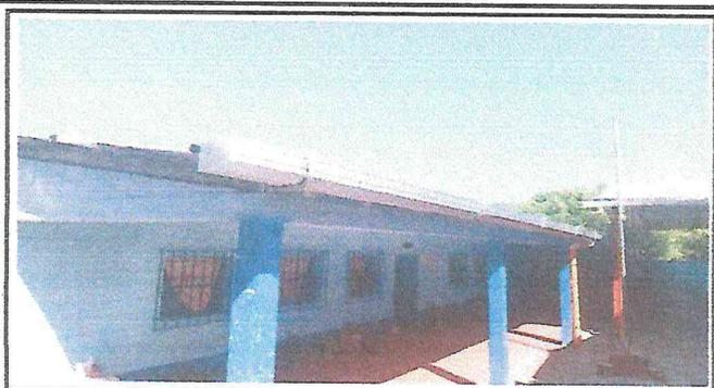
Foto 2: canales recolectores de aguas pluviales instalados listos para recolectar las aguas pluviales propias de las estaciones.
